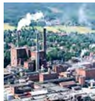
Pilotanläggningen för nanokristallin cellulosa byggs i anslutning till Bio-refinery Demo Plant i Örnsköldsvik.
